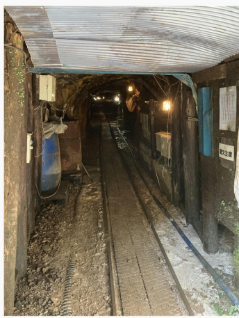
坑道内の様子
