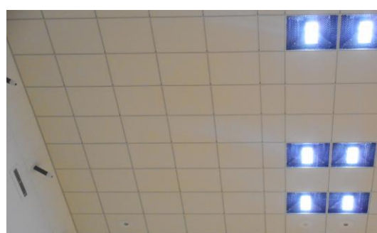
安全性が確保された真新しい天井
